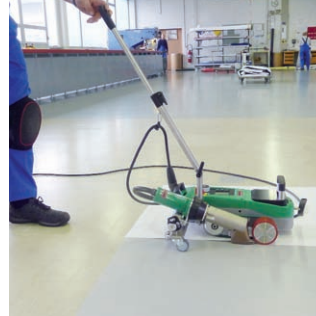
Konstante, faltentfreie Überlappschweißungen
